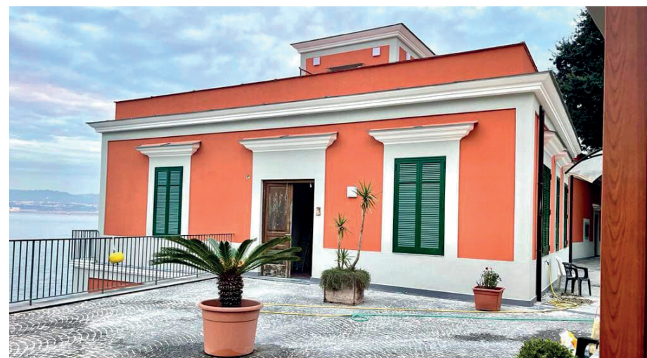
Villa Ferretti – dopo i lavori di recupero
