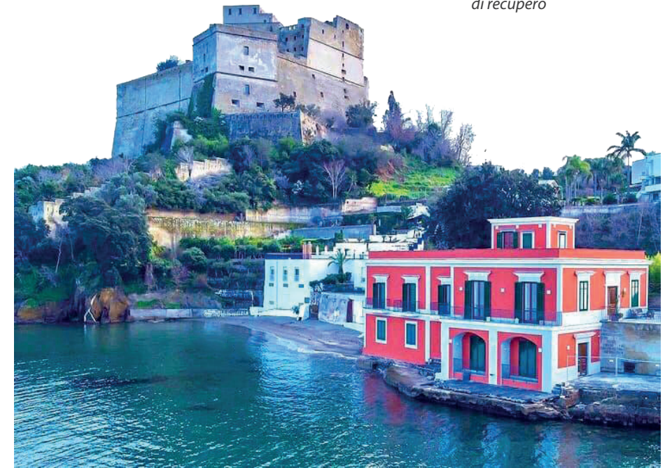
Villa Ferretti dopo i lavori di recupero
