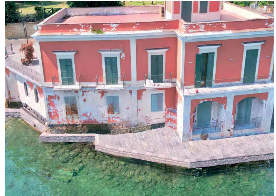
Villa Ferretti – prima dell'intervento di recupero
